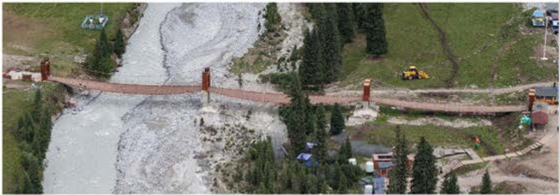
图 3 将军桥事故现场照片
